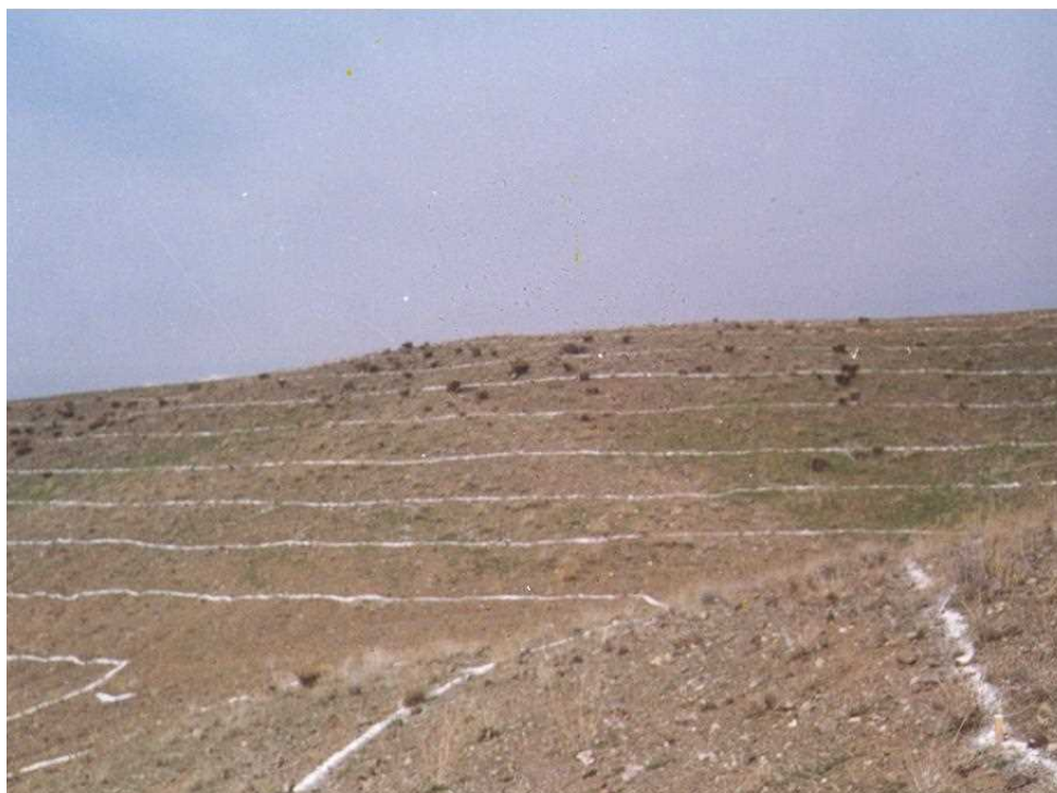
شکل شماره ۴-۱- تعیین خطوط تراز با توجه به وضعیت توپوگرافی زمین
